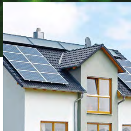
AURINKOSÄHKÖMODUULIT JA INVERTERIT
