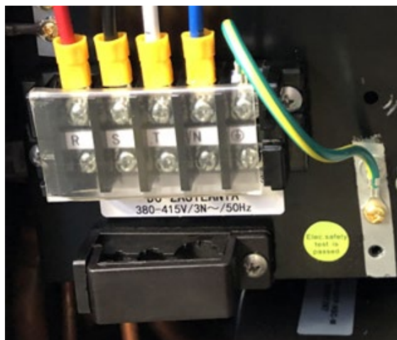
Złącze zasilania urządzenia.
